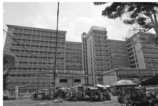
写真1 チョーライ病院外観
