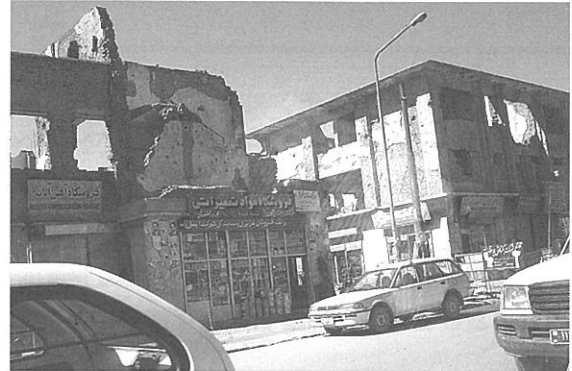
アフガニスタン・カブール市 砲弾を浴びた建物
