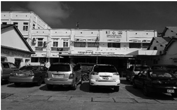
写真3 活動していた州病院(一番新しい建物)
